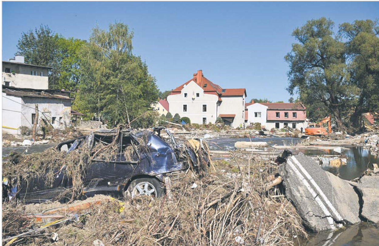
W Stroniu Śląskim woda zniszczyła wszystko na swojej drodze, również infrastrukturę komunalną
