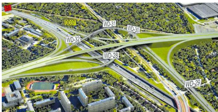
• Wizualizacja nowego wjazdu do Warszawy, czyli ekspresówki S7 na odcinku Kielpin - Warszawa. Rejon węzła z obwodnicą S8, czyli al. Obrońców Grodna. FOT. GDDKIA/YT
