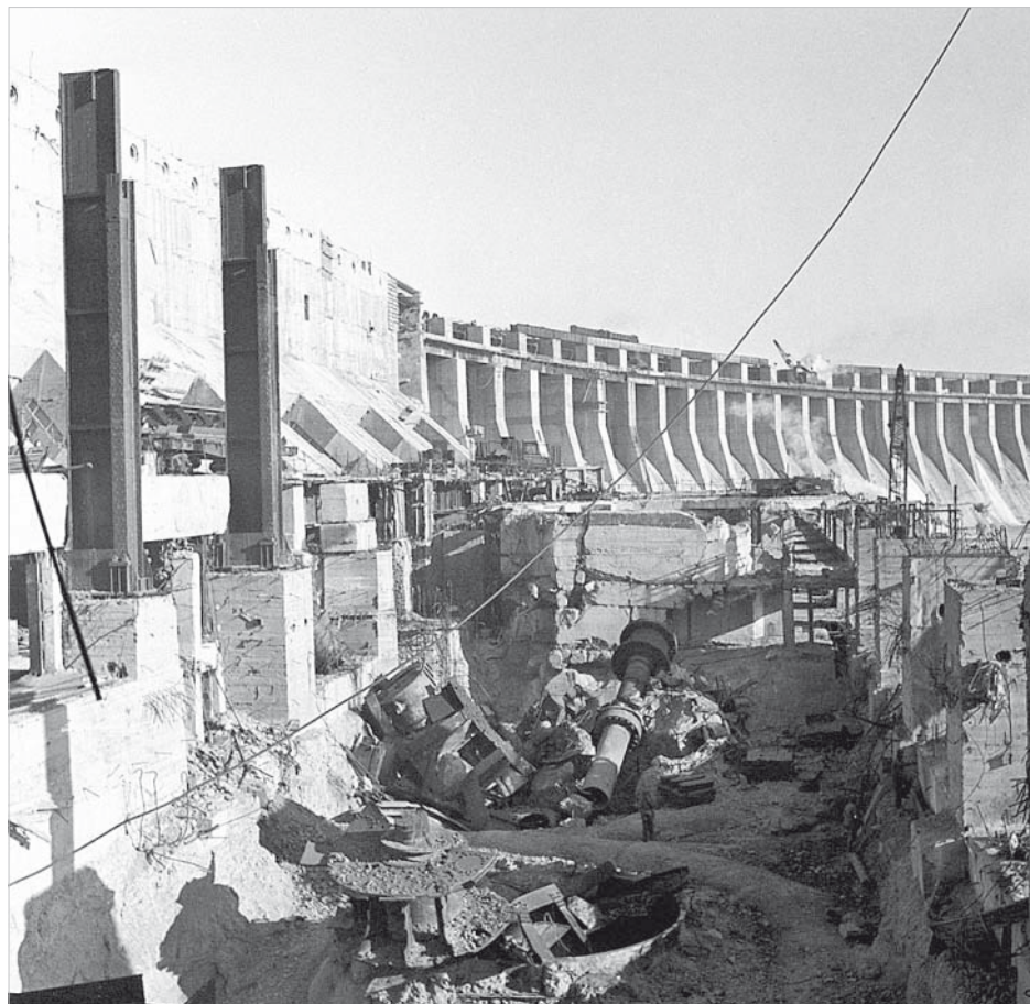
Zapora elektrowni po zniszczeniu przez wycofujących się Niemców w 1943 r.
